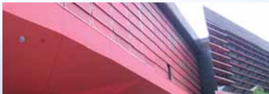
Chantier SOFRAMAP réalisé en MURNYL "PLUS" Musée du Quai Branly - Paris
